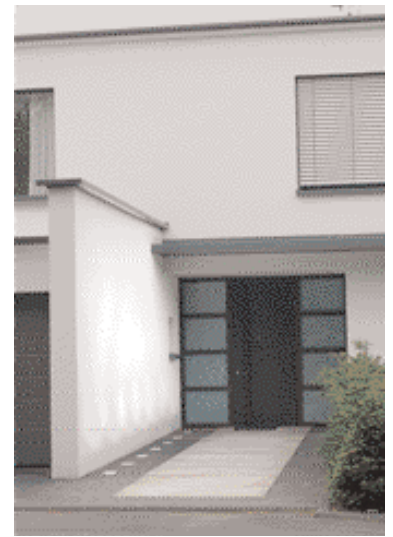
Durch Bodeneinbauleuchten mit diffuser Abdeckung, erhält die Leitwand zum Eingang hin gestreutes Licht. Die Leuchten selbst werden in ihrer Reihung als Leitlinie wahrgenommen.
